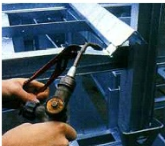
Abb. 2: Mit Hilfe einer Flamme können "festgelötete" Scharniere wieder gängig gemacht werden
