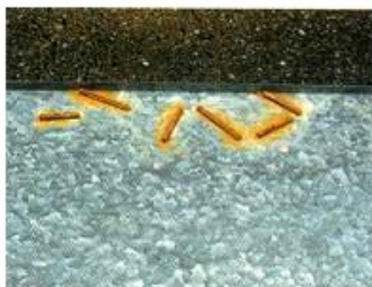
Abb. 4: Reste von Schweißelektroden können sog. "Fremdrost" verursachen
