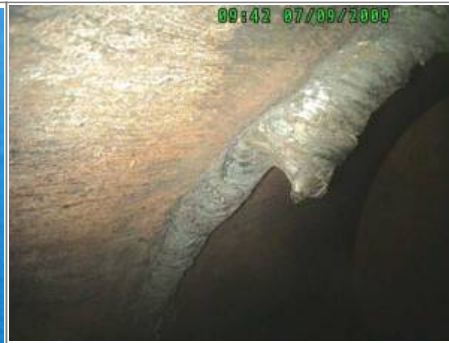
Bild 15: Wurzelüberhöhung
