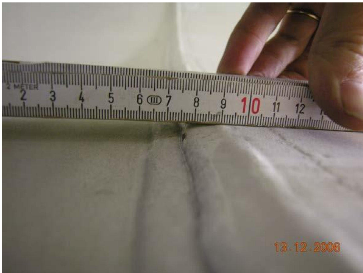
Bild 19. Kantenversatz
