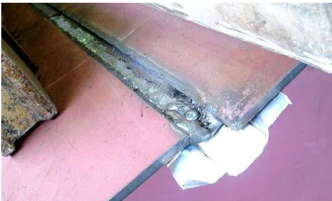
Bild 4. Sichtprüfung während des Schweißens, Riss in Zwischenlage
