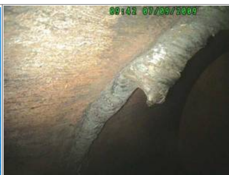
Bild 15: Wurzelüberhöhung
