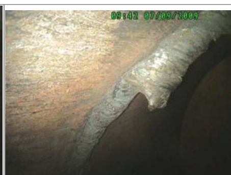
Bild 16: Schweißgutüberlauf
