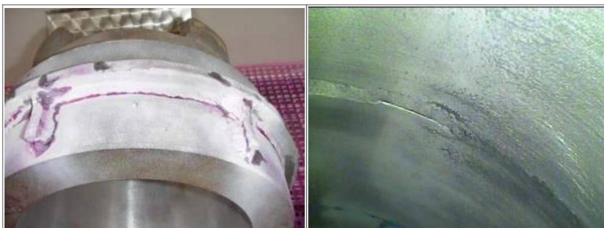
Bild 12. Bindefehler zur Oberfläche hin offen
