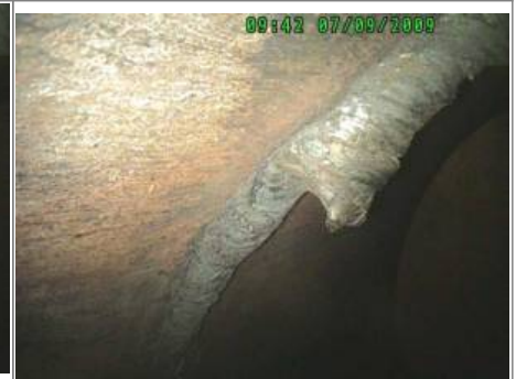
Bild 16: Schweißgutüberlauf
