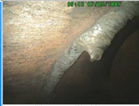
Bild 15: Wurzelüberhöhung
